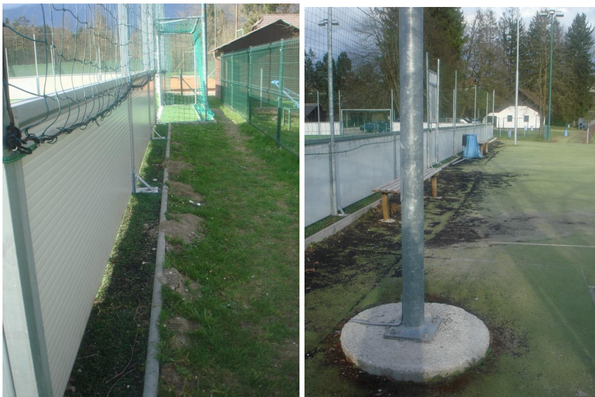
Slika 8: Obod igrišča z robniki in temelji za razsvetljavo
