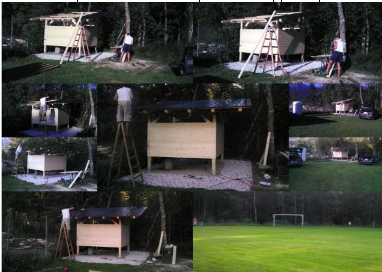
Slika 10: Izgradnja preprostega vendar učinkovitega sanitarnega bloka
